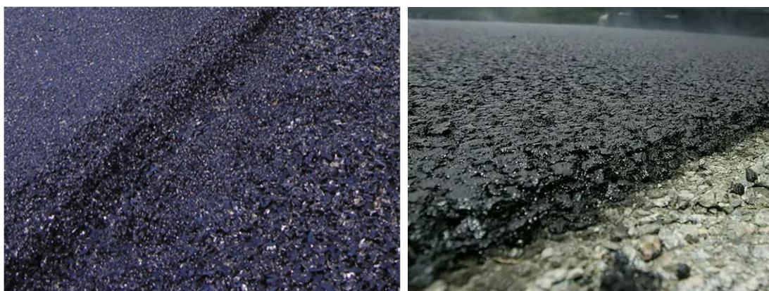
Рисунок 1.11 Резиновая крошка в верхних слоях асфальта [50]
